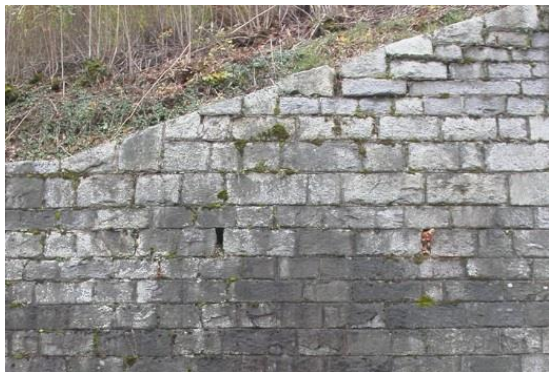
Foto 8: Mauerkrone leicht verschoben
