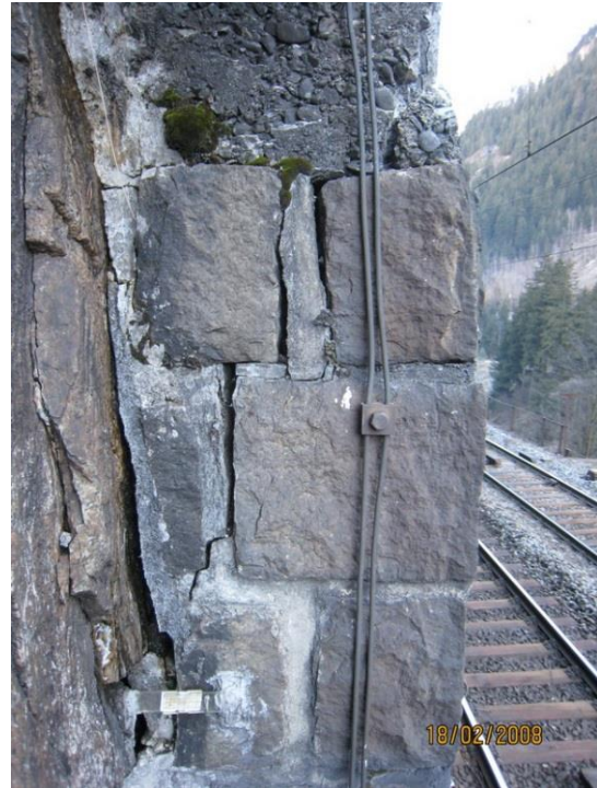
Foto 16: oberflächlich geflickte Fugen, Anzeichen von Staunässe (dünne Verkleidungsmauer)
