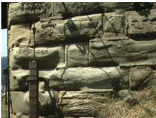
Foto 21: Absanden von Berner Sandstein (Oberflächenphänomen)
