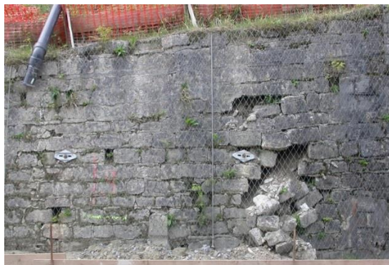
Foto 20: Nester von losen Mauersteinen (Einsturzgefahr trotz intakter Steine)
