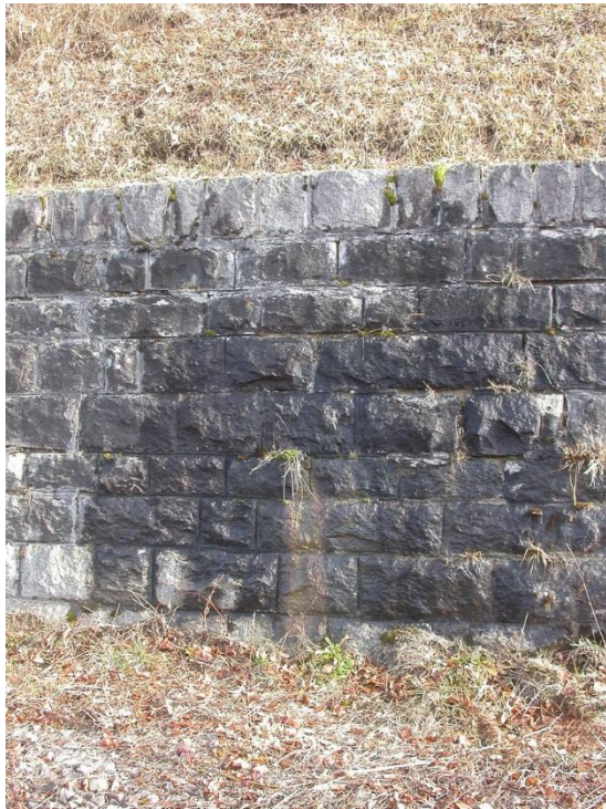
Foto 3: Schlammaustritt aus Entlastungsöffnung
