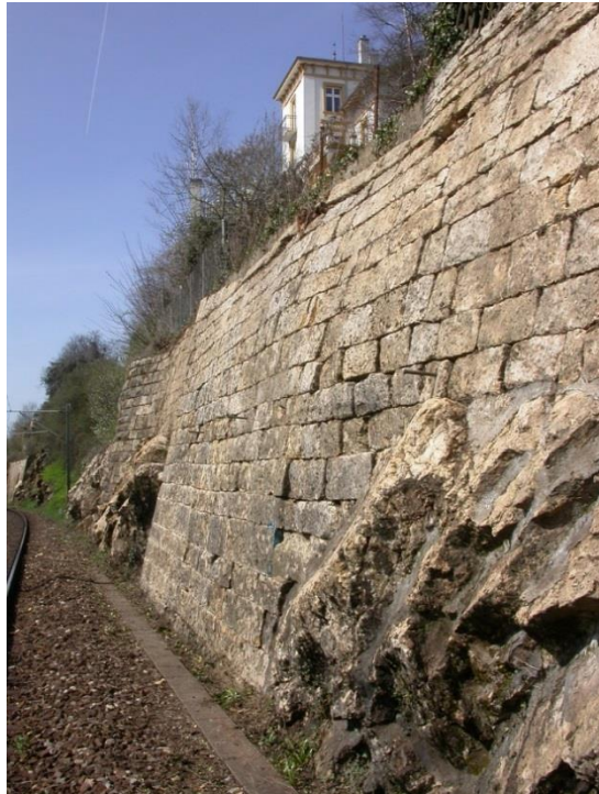
Foto 12: feine Risse entlang Fugen, erkennbar an feiner Vermoosung entlang den Fugenflanken
