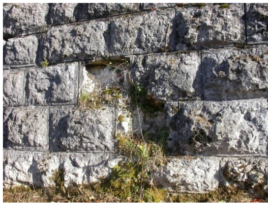
Foto 22: einzelne tief verwitterte Mauersteine (Bröckelzerfall von Kalkstein)
