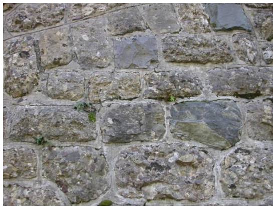
Foto 12: feine Risse entlang Fugen, erkennbar an feiner Vermoosung entlang den Fugenflanken
