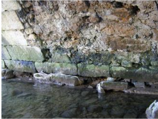
Foto 5: Unterspülung Mauerfuss
