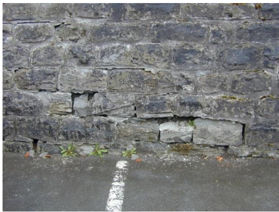
Foto 21: Absanden von Berner Sandstein (Oberflächenphänomen)
